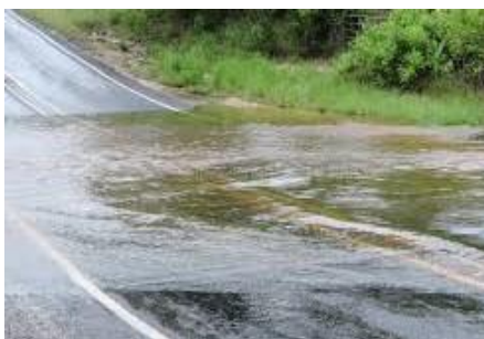
FIGURA W8. Cruce de aguas bajas cerca de una carretera.
